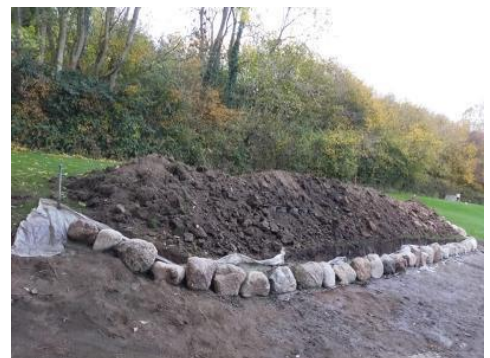
Bild 6: entstehende Feldsteinmauer am Abschlag 3
