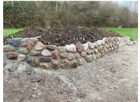
Bild 6: entstehende Feldsteinmauer am Abschlag 3
